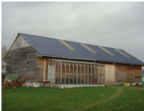
Le hangar et la serre à plants, construits en 2008
